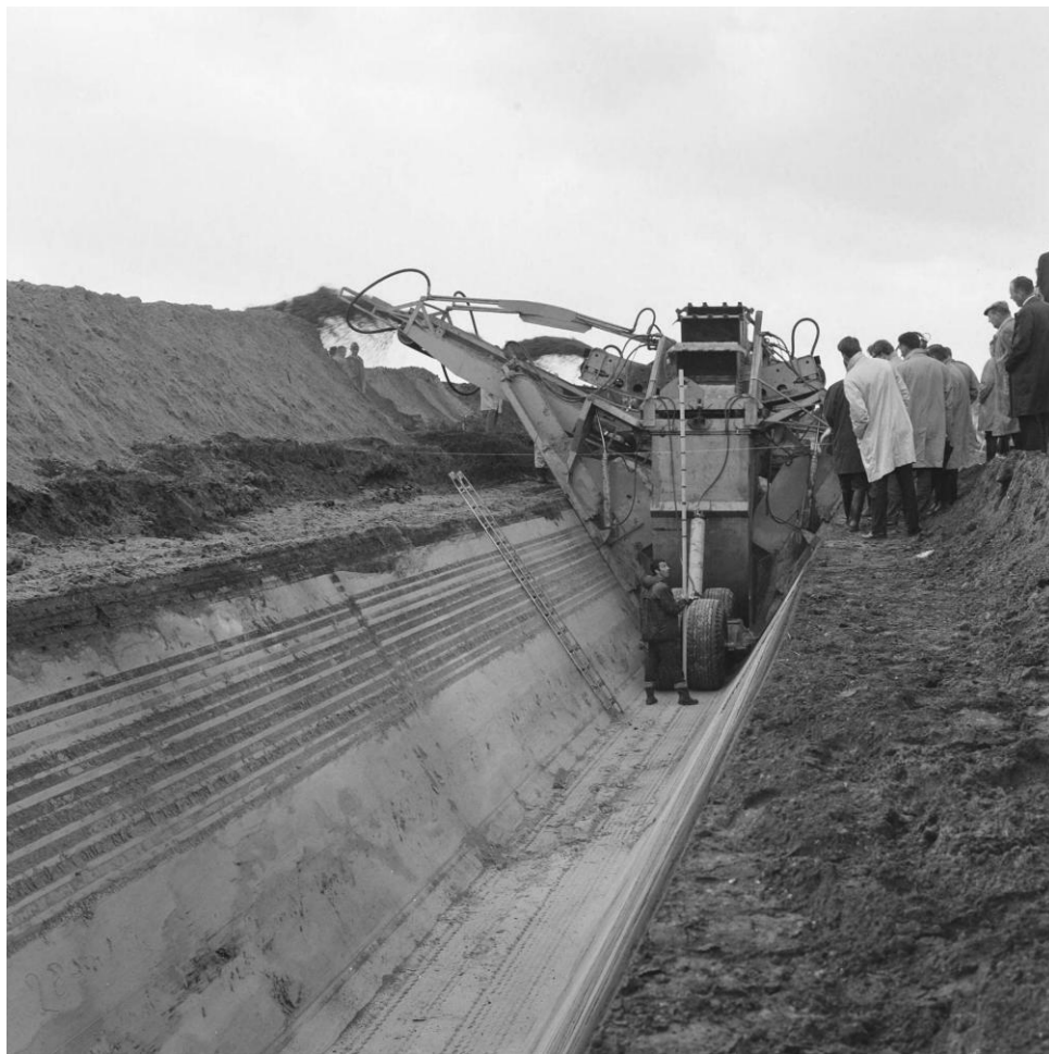
Afbeelding 4 : Fotocollectie Nederlandse Heidemaatschappij, Horizontale bronbemaling hoofdaardgastransportleiding (Wüllschleger, [...] / Heidemij), Nationaal Archief, CC0, 1967-07
